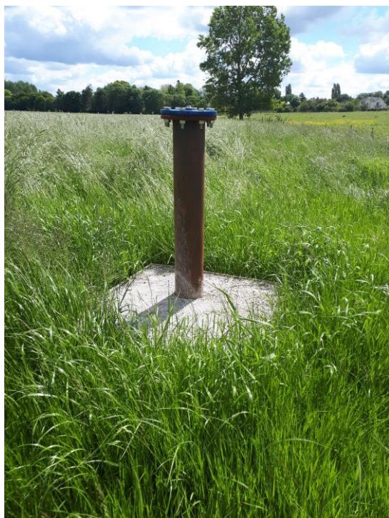
Vue sur le piézomètre aux alluvions
